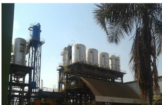
**Figura 23.** Colunas de destilação.
